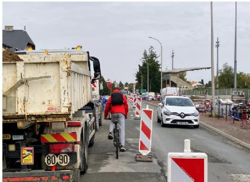
Les riverains redoutent un accident avec les cyclistes ou les trottinettes qui circulent à leurs risques et périls à contresens et sur des voies en travaux. (Photo NR-CP, Emmanuel Coupaye)
